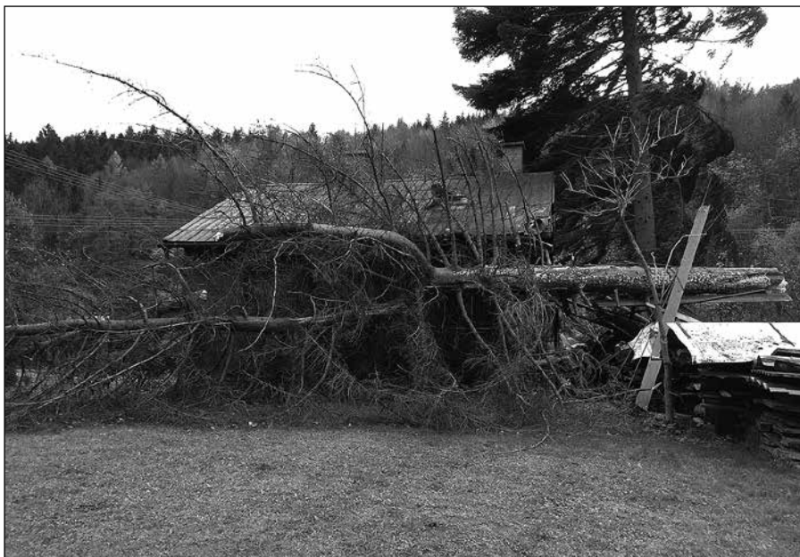
Strom spadlý na chatu
