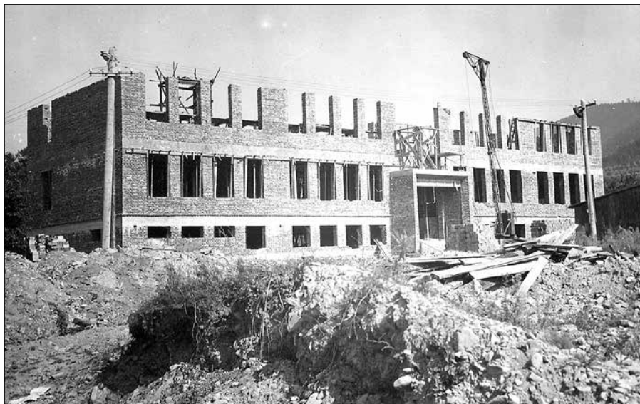
Stavba nové školy
