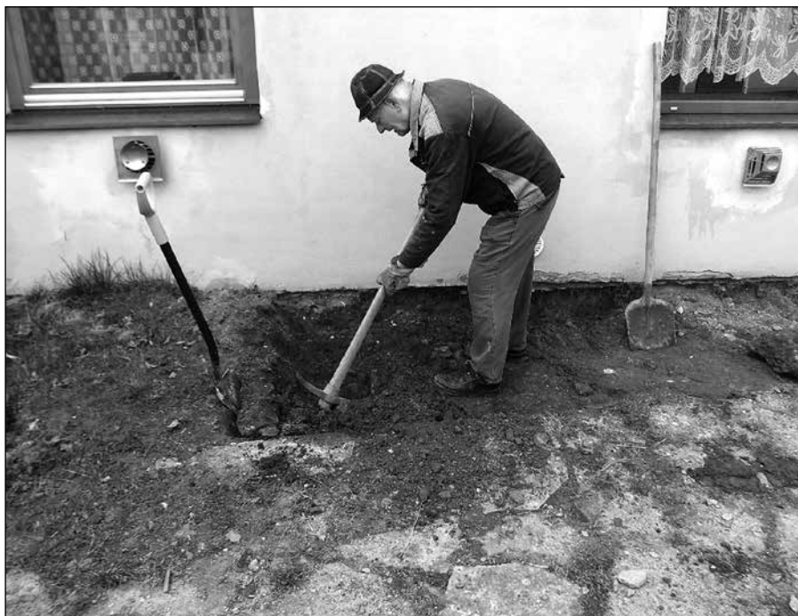
Práce na dlažbě na Chalupě
