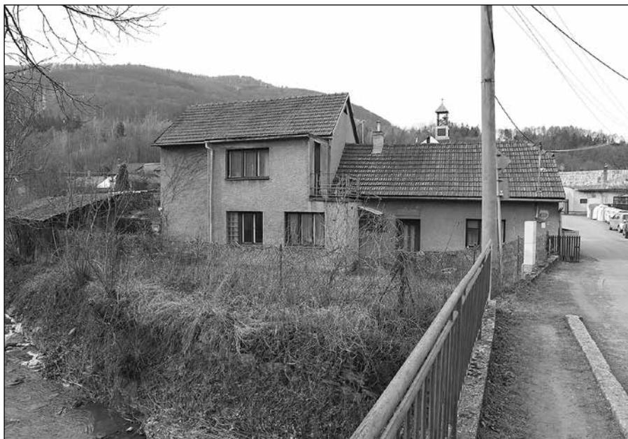
Na Kůtku – před rekonstrukcí
