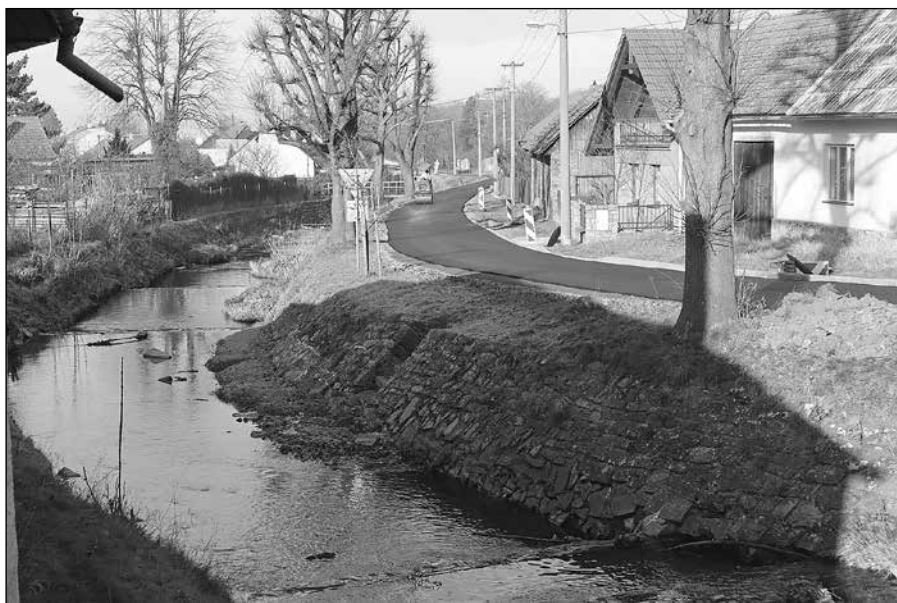
Oprava silnice Na Kůtku
